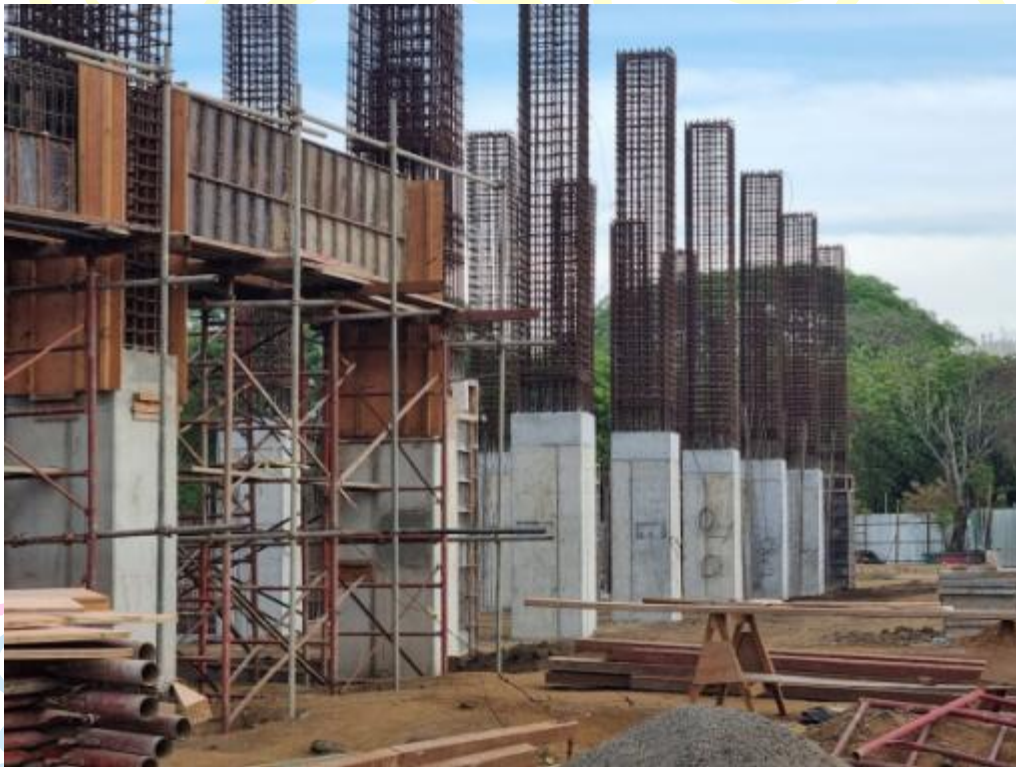
Columnas Edificio A
