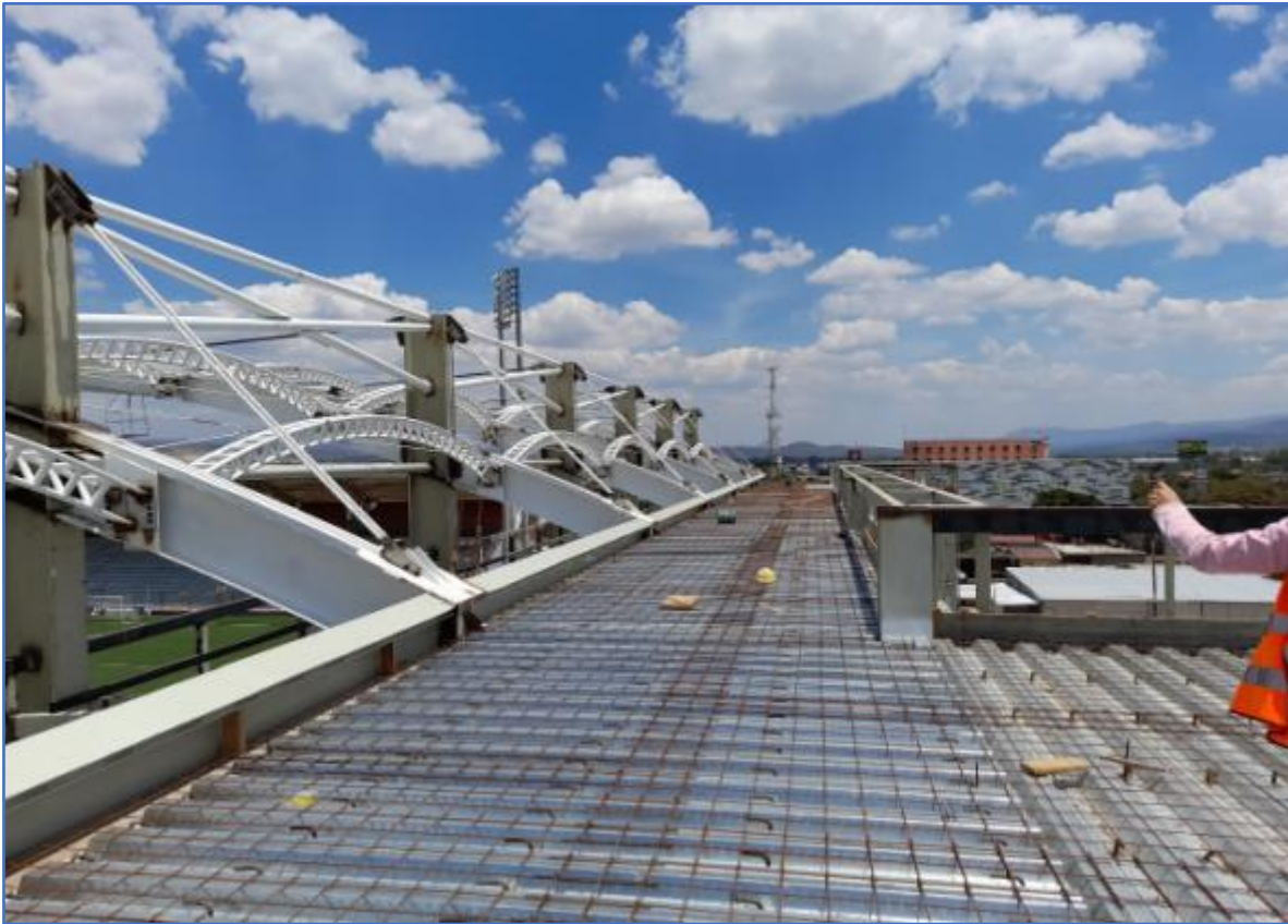
Foto N° 3: Nivel 13. Formaleta metálica y acero de refuerzo para losa
