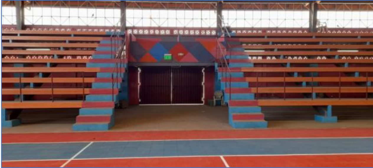
Fachachada interna mostrando graderías pintadas, rotulos de emergencia y salida instalados y porton metalico nuevo.
