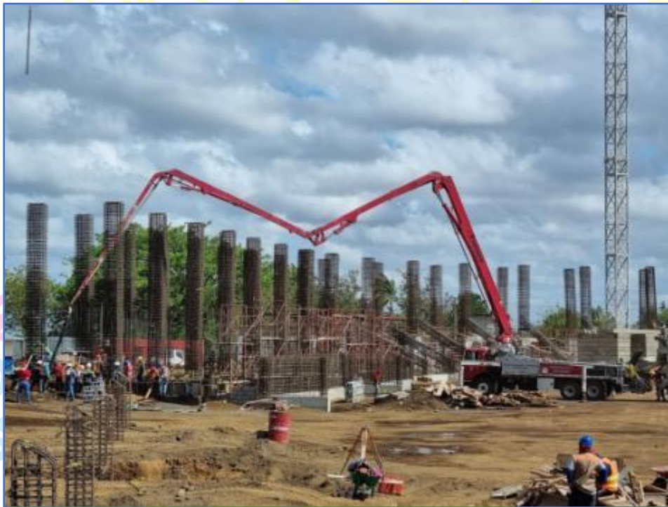
En ambas fotografías se muestra el proceso de colado de columnas Edificio B
