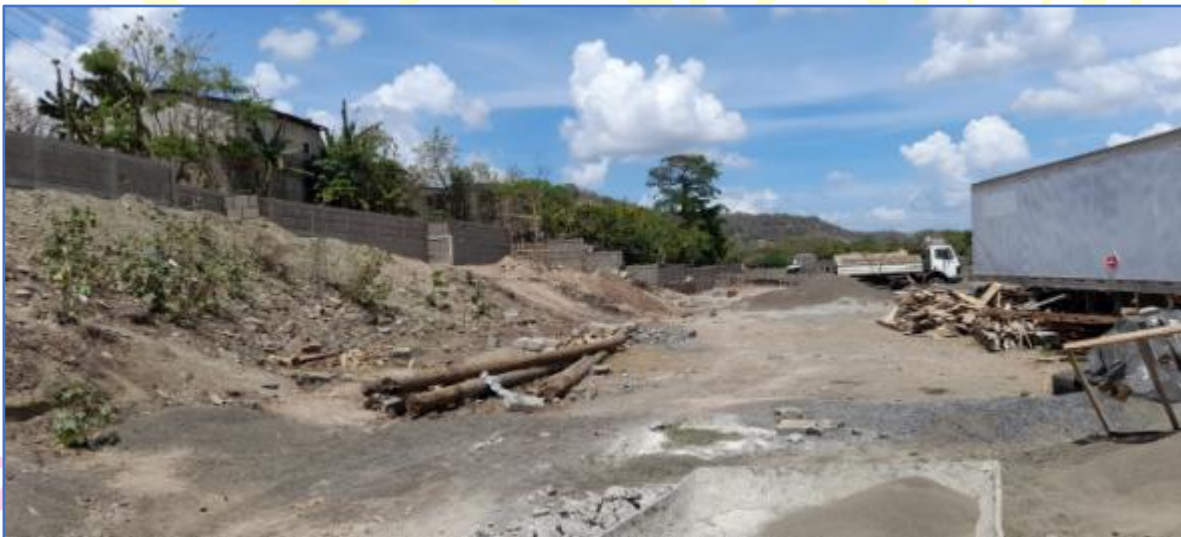
Muros en el sector este finalizados
