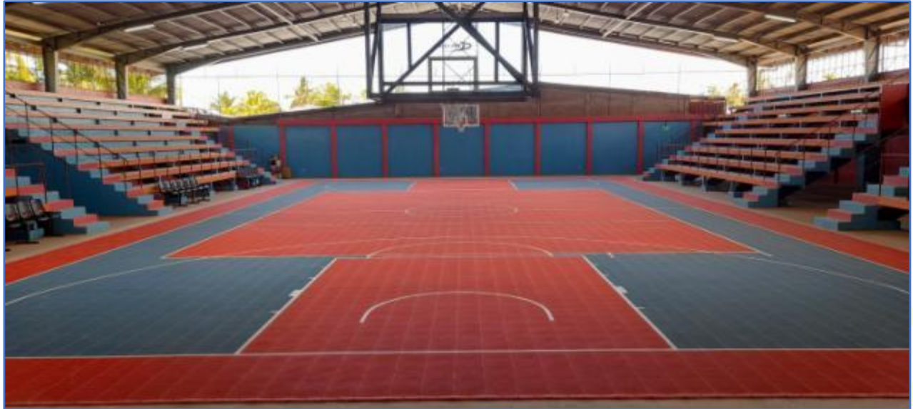
Piso sintético tipo versacoat instalado en cancha.
