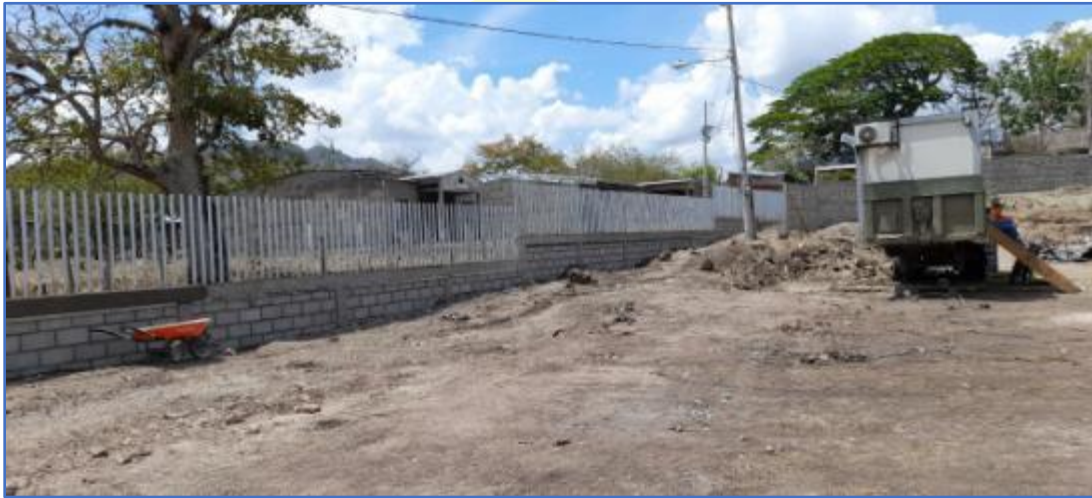
Foto mostrando el muro fachada y tubos galvanizados instalados.
