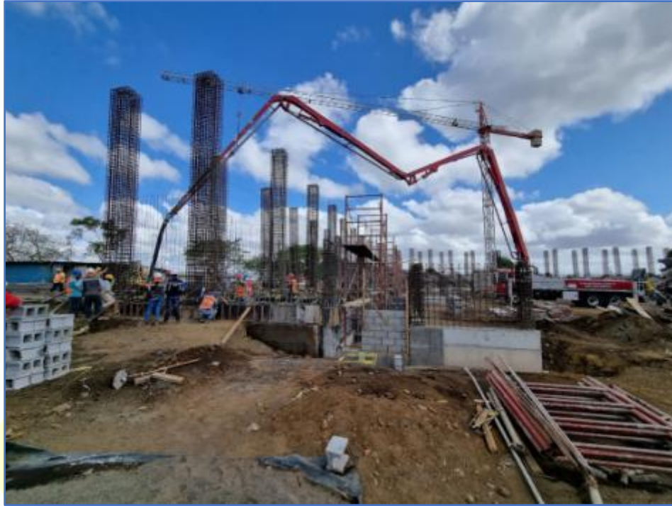
En ambas fotografías se muestra el proceso de colado de columnas Edificio B
